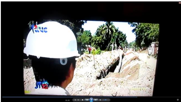
水道配管埋め立て工事の様子
