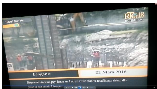
給水塔建設工事の様子
