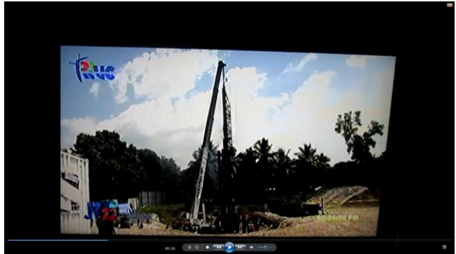
給水塔建設の様子
